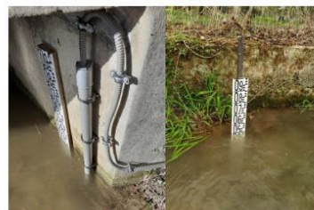
Station limnimétrique sur l'Echelle (commune de Sarat) et échelle limnimétrique sur le Jovart (Montignac-Charente)
