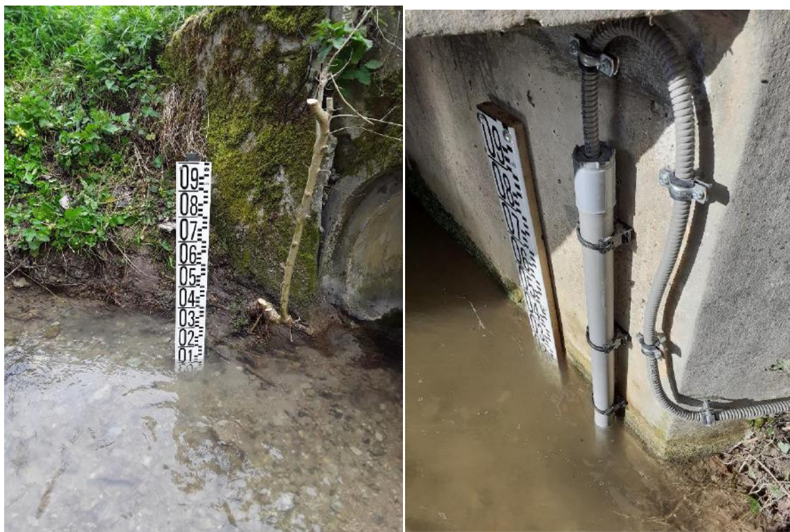
Échelle installée sur la Boème (gauche), et station de mesures sur le cours de l'Échelle (droite)
