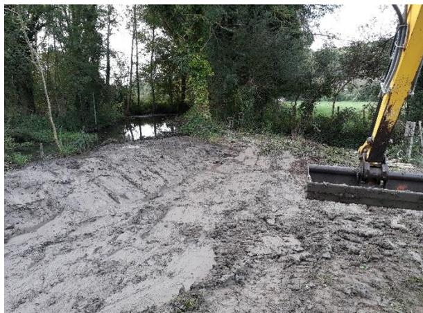
Des fuites ont été localisées sur le bief de l'usine de Poulet et ont nécessité un aménagement de type protection de berge. L'exploitant de la parcelle a ensuite reculé la clôture afin que le bétail ne revienne dégrader la berge.
