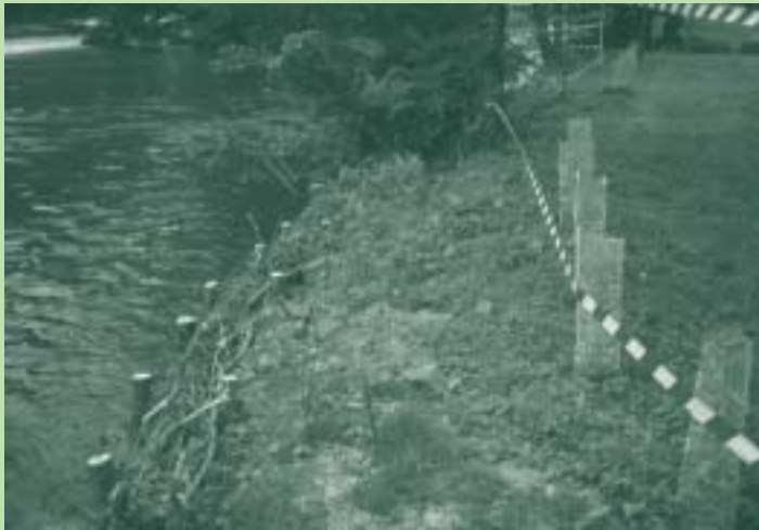
Protection de berge mis en place à Gond-Pontouvre
