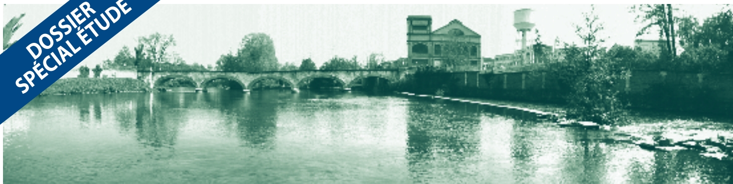
L'étude a porté aussi sur les ouvrages d'art, ici le pont en aval de DCNS à Ruelle-sur-Touvre.
