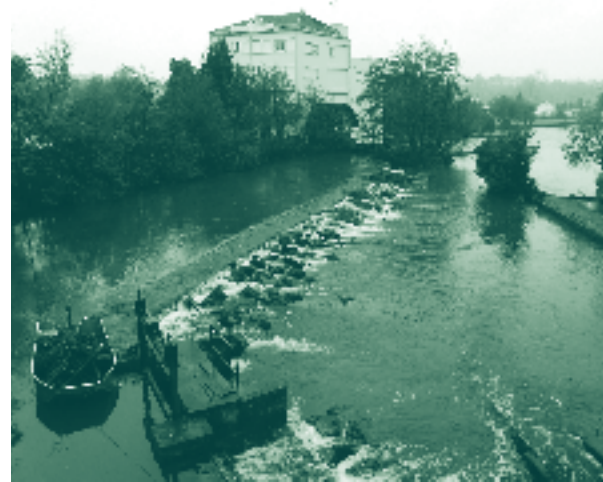
Moulin du Pontouvre (Gond Pontouvre). Ce site classé non prioritaire nécessitera néanmoins des travaux correctifs pour le franchissement piscicole.
