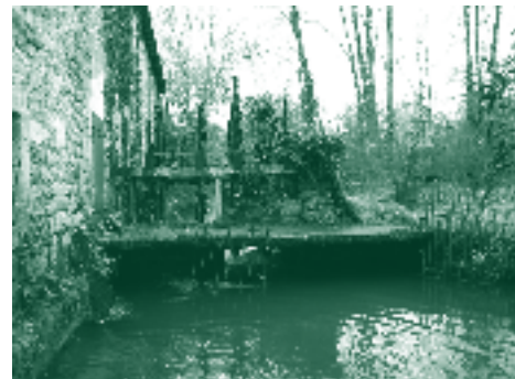
Moulin de la Maillerie (Touvre) a été classé comme site prioritaire notamment pour être non franchissable.
