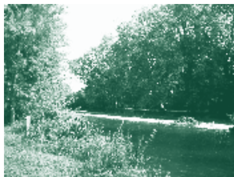
Situation après intervention
